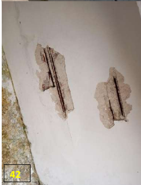
Figura 40 e 41 - Visão geral da escada; figuras 42 e 43 - Área sob a escada com ferragem exposta.
