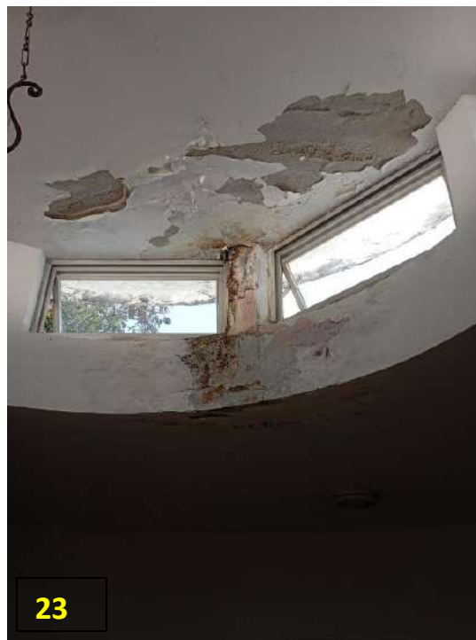
Figura 22 - Infiltração hall entra do Gama ; figura 23 - infiltração no hall das salas
