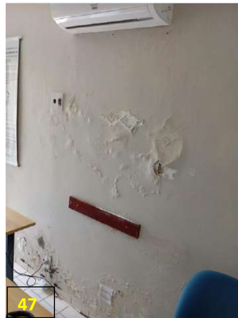
Figura 44- Ar condicionado que precisa ser alterado de lugar, as figura 45 e 47 mostram as paredes internas com as infiltrações, a figura 46 mostra o ar condicionado na outra lateral do prédio com problema de infiltração devido o dreno.
