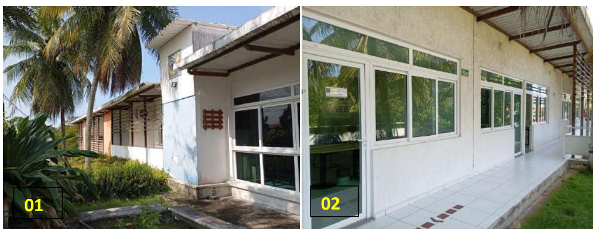
Figura 1 - Fachada Principal ; figura 2 - Fachada Posterior
