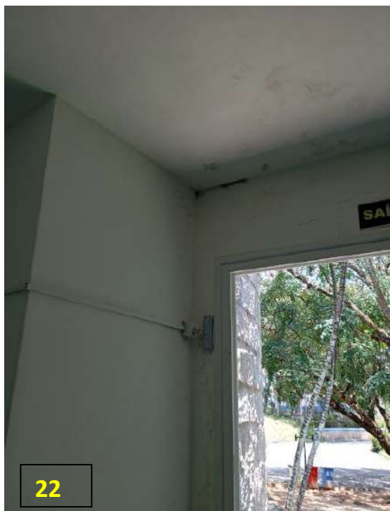
Figura 22 - Infiltração hall entra do Gama ; figura 23 - infiltração no hall das salas
