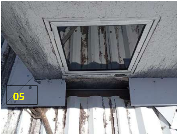
Figuras 03, 04, 05 e 06 - Avarias no rufo da caixa d'água.
