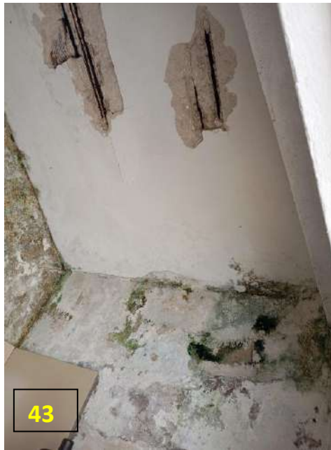
Figura 40 e 41 - Visão geral da escada; figuras 42 e 43 - Área sob a escada com ferragem exposta.
