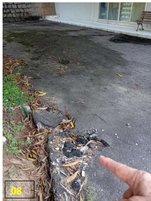
Figuras 07 e 08 - Vazamento da tubulação sob o asfalto
