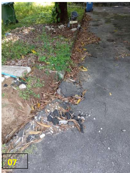
Figuras 07 e 08 - Vazamento da tubulação sob o asfalto
