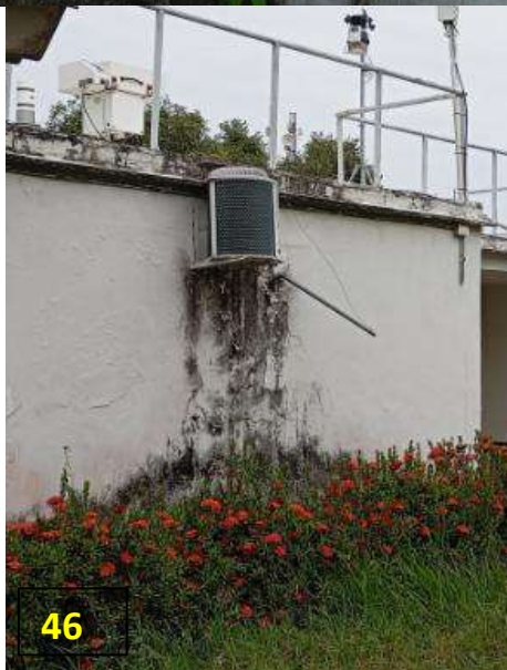
Figura 44- Ar condicionado que precisa ser alterado de lugar, as figura 45 e 47 mostram as paredes internas com as infiltrações, a figura 46 mostra o ar condicionado na outra lateral do prédio com problema de infiltração devido o dreno.
