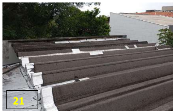
Figura 20 - Vista geral do telhado do prédio Gama; figura 21 - Vista de detalhes do conserto com manta asfáltica realizado anteriormente.
