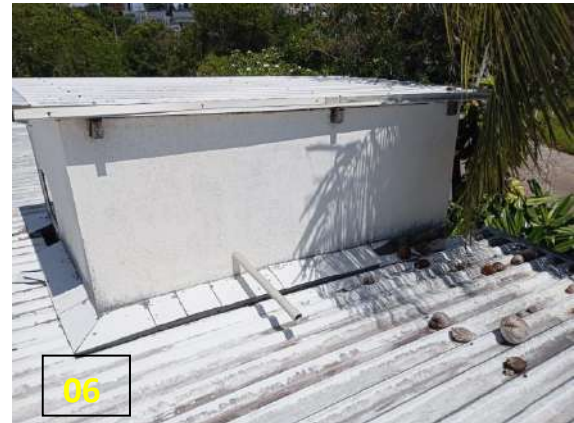
Figuras 03, 04, 05 e 06 - Avarias no rufo da caixa d'água.
