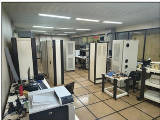
Figura 2 – Interior da Sala 114
